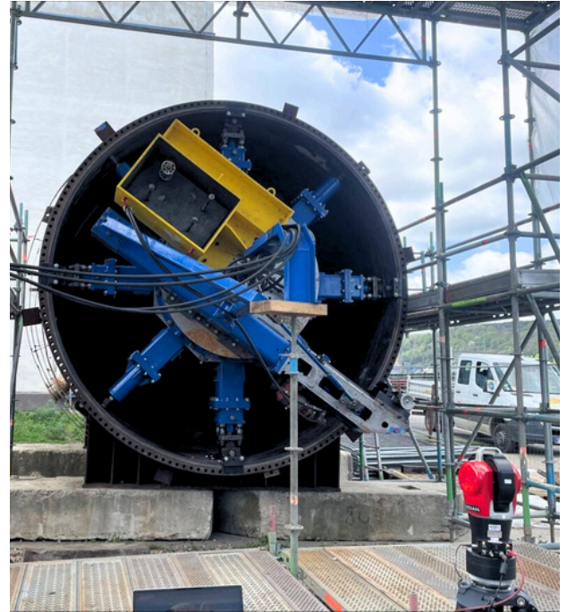
Réglage de machine d'usinage pour une correction parfaite des défauts existants / Adjustment of the machining machine ensures perfect correction of existing defects
