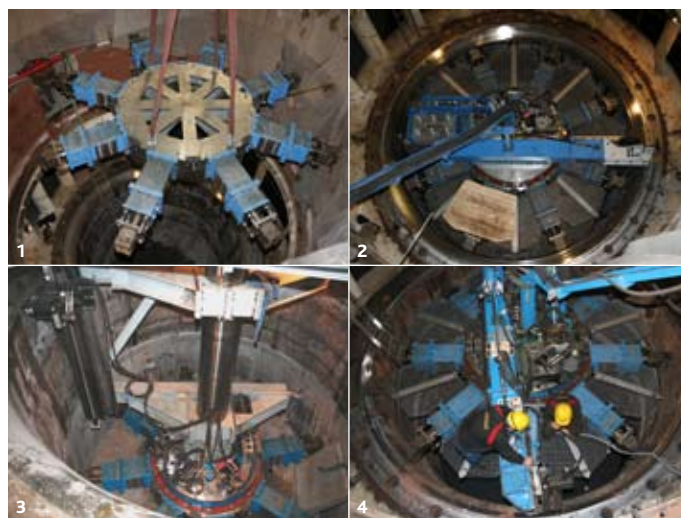
1- Mise en place machine. 2- Usinage rayon. 3- Alésage Ø 6700. 4- Fraisage.
