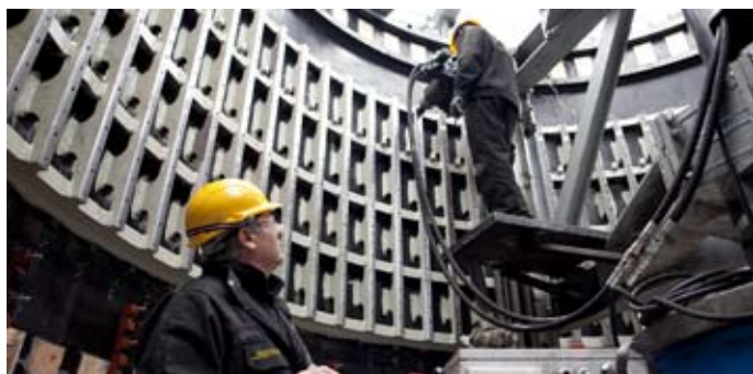
Centrale hydraulique : Alésage stator Ø 5500, usinage 69 barreaux, hauteur 2 000, tolérance 0,2.
